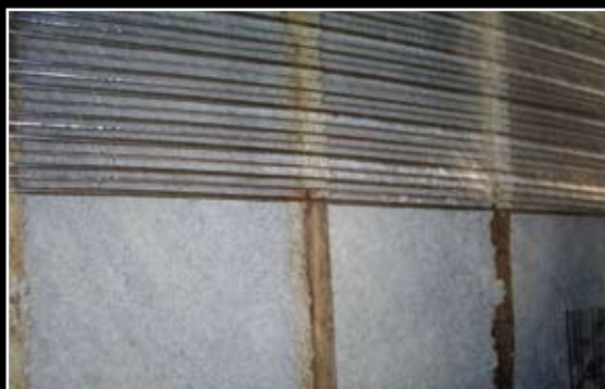
Soporte de aislamientos
