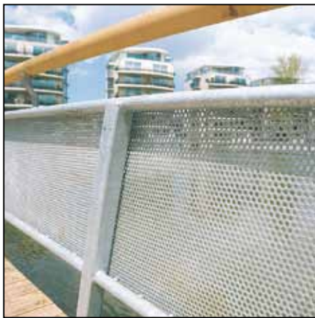
◀ Lochbleche mit Rundlochung im Einsatz als Brückenverkleidung. Sie wurden nachträglich feuerverzinkt und auf einen Rahmen aufgenietet. Der Handlauf unterstreicht das ansprechende Gesamtbild.
