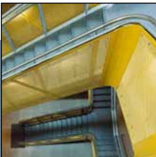
◀ Pulverbeschichtete Rundlochbleche verkleiden die Erschließungstrepfen im rekonstruierten Bismarckturm in Dresden. Dank der individuell angepassten Ränder können die Bleche ohne zusätzliche Rahmung umlaufend montiert werden.
